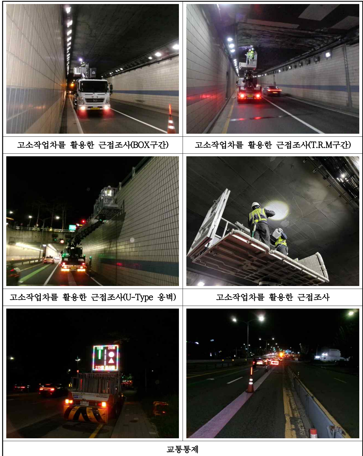
【사진 3.1.1】외관조사 전경
