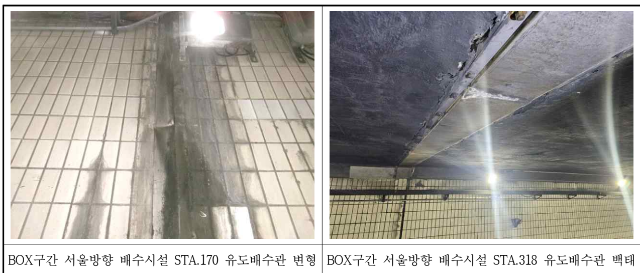
【사진 3.3.11】 배수시설 외관조사 결과
